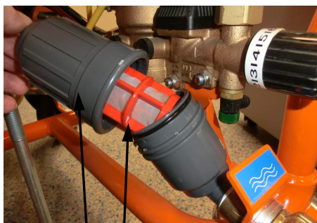
Рис. 99: Очистка сетки
