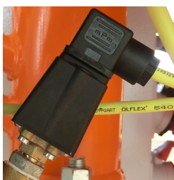
Рис. 101: Мембранный выключатель по воде
