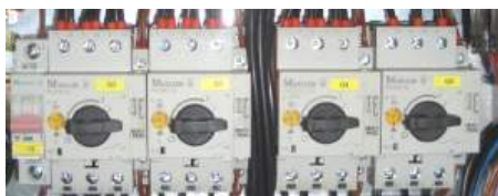
Рис. 1: Защитный выключатель электродвигателя
